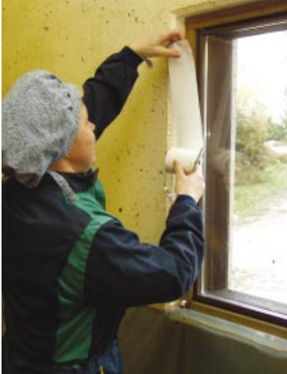
▲ Ikkunoiden ja ovien tiivistämiseen paalinkorjausteippi on hyvää. Se tarttuu kunnolla ja raot menevät umpeen.
